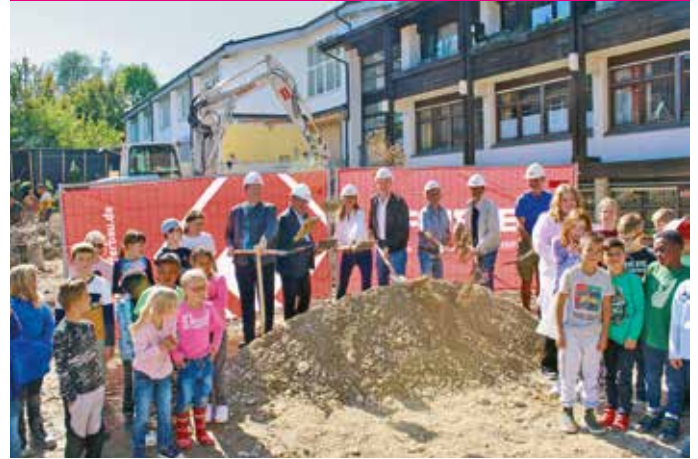
Die Kinder freuen sich auf ihre neue Schule. Beim Spatenstich mit dabei: Der stellvertretende Miesbacher Landrat Josef Bierschneider, Bürgermeister Klaus Meixner, Dorfleiterin Pia Klapos, Patrick Friedrich, HSP Bauunternehmen GmbH, Schulleiter Thomas Wimmer, Verwaltungsleiter Hannes Klapos und Hausmeister Manfred Troger (v. l.). Nicht im Bild Jutta Betsch vom Architekturbüro Schmuck.
